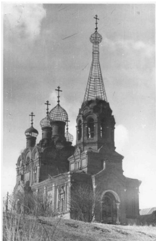
Фото 1. Вид с северо-запада. Снимок 04.04.1990 г.
